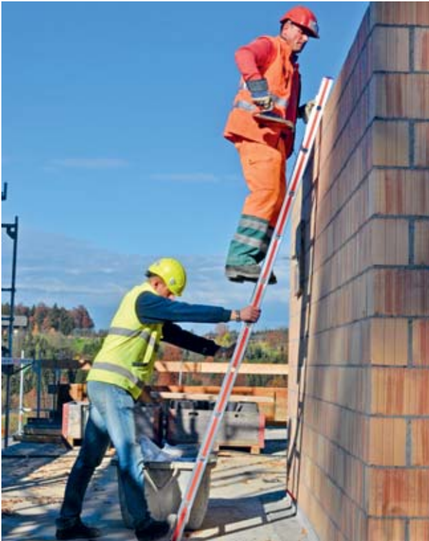
Fig.22: scala messa in sicurezza da una persona
