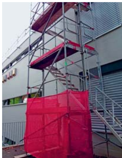
Fig. 12: torre scala per ponteggio
