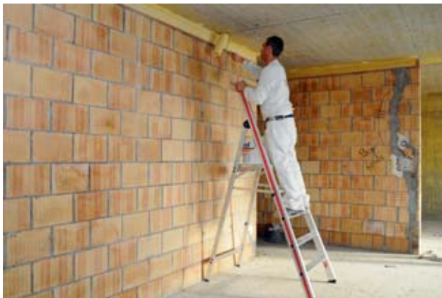
Fig. 47: scala doppia a gradini con piattaforma e dispositivo di sostegno
