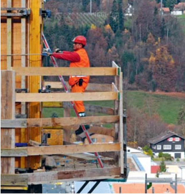
Fig. 4: ulteriori misure di protezione (protezione laterale più alta) in caso di postazione sopraelevata
