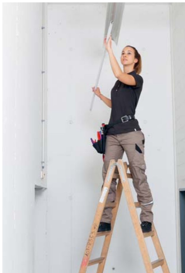
Fig.42: stando sul terzultimo piolo il lavoratore si sostiene con le gambe ai due pioli più in alto.
