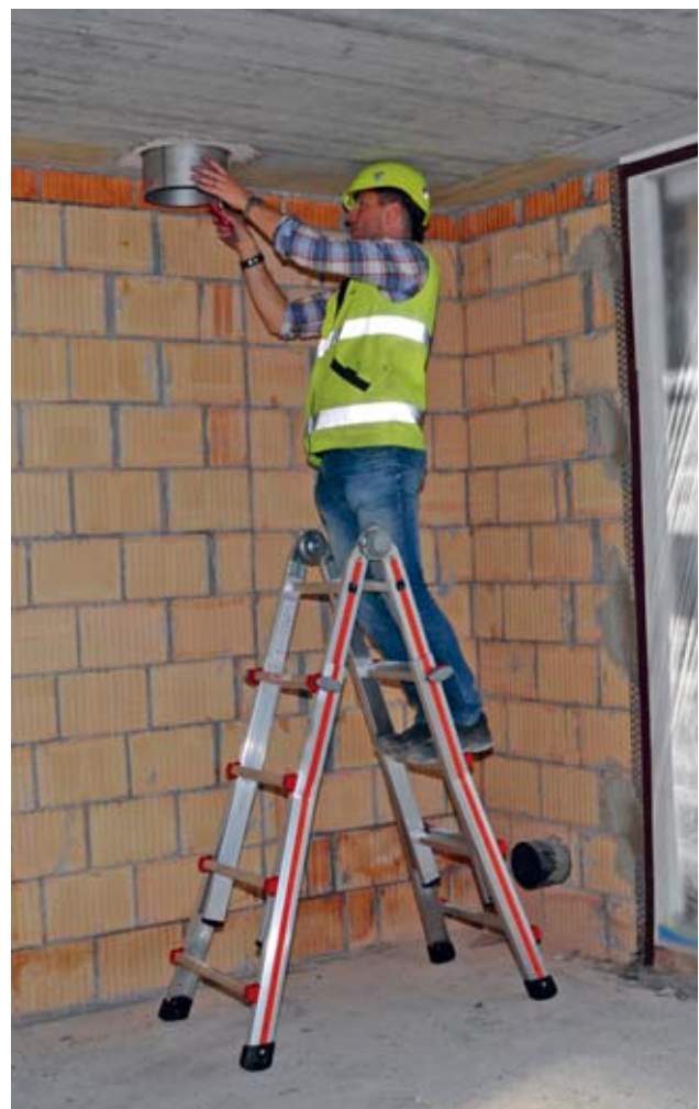
Fig. 50: scala combinata, utilizzabile come scala semplice, scala doppia e scala doppia per gradini
