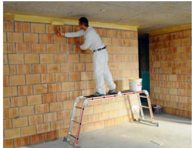
Fig. 49: scala multiuso, utilizzabile anche come piattaforma di lavoro
