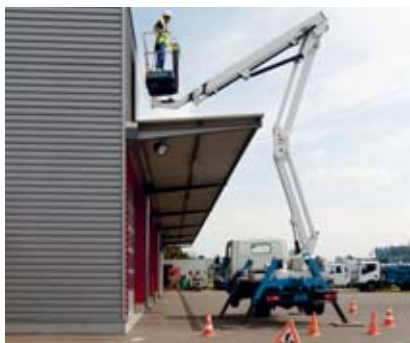
Fig. 7: piattaforma di lavoro mobile con braccio telescopico
