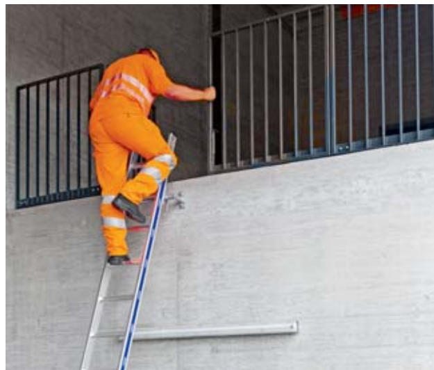
Fig. 15: dispositivo di trattenuta, parapetto sul lato aperto e testa della scala messa in sicurezza
