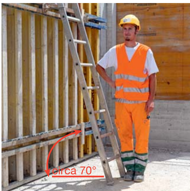
Fig. 17: verifica dell'angolo di inclinazione con il gomito
