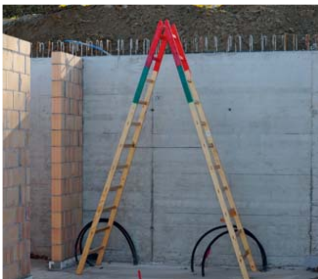
Fig.41: vietato salire sugli ultimi due pioli in alto.
