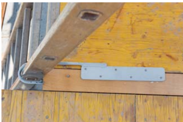
Fig. 26: fissaggio tramite gancio
