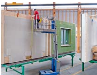
Fig. 6: piattaforma di lavoro elevabile, con movimento verticale
