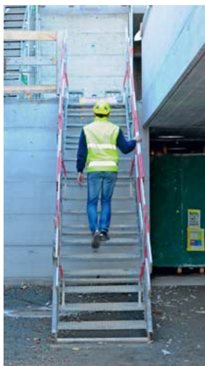
Fig. 9: scala a gradini da cantiere
