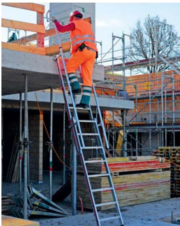
Fig. 16: montanti prolungati per l'accesso sicuro
