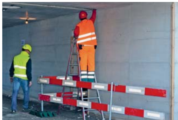
Fig. 3: messa in sicurezza della scala in una zona di transito
