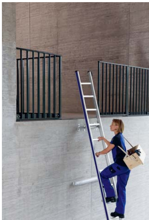
Figg.30 e 31: sguardo e corpo rivolti verso la scala, mani sui pioli e contenitori adeguati (cassetta o tasca portaattrezzi)
